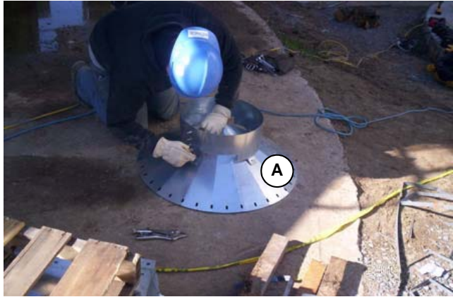
A. Plenum cone with fill hopper B. Plenum center cone
