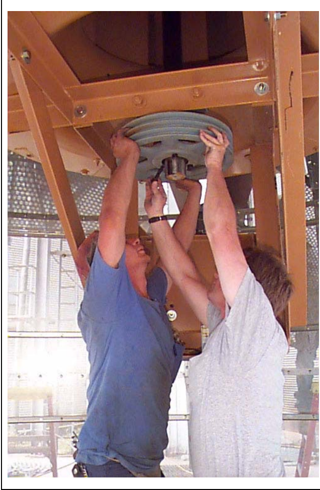
Figure 16U Sliding fan sheave on fan drive shaft.
