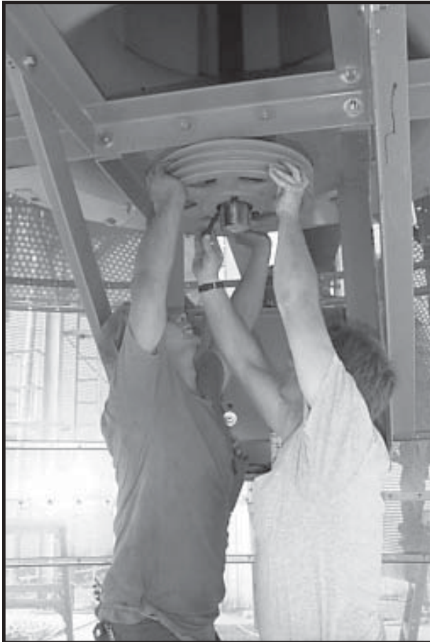
Photo 14-21 Sliding Fan Sheave on Fan Drive Shaft.
