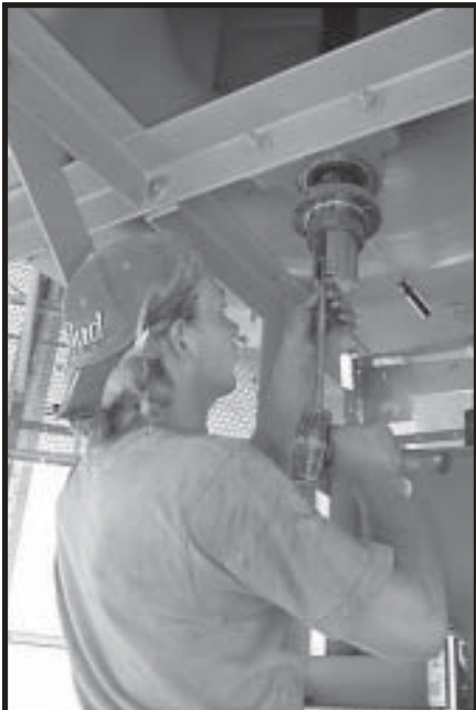
Photo 14-19 Placing Fan Hub Key in Fan Hub.
