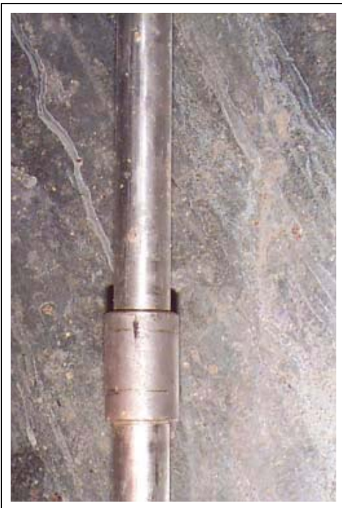
Figure 7J Close Up - Conduit Coupling
