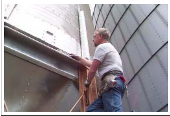
Figure 12R Leveling Conduit
