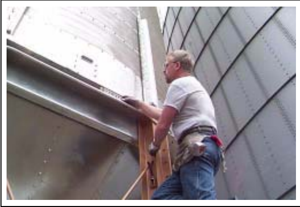
Figure 12R Leveling Conduit
